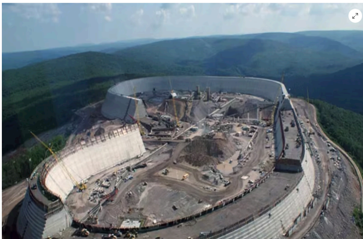
Ett amerikanskt exempel. Den övre dammen vid Tom Sauk rasade.
