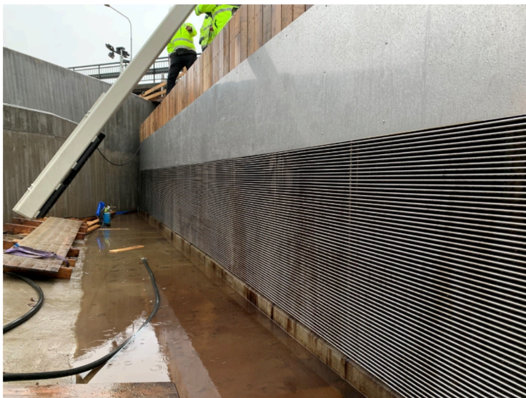
Lyckeby kraftverk har nu fått ett nytt dyrt fiskgaller av senaste modell.
